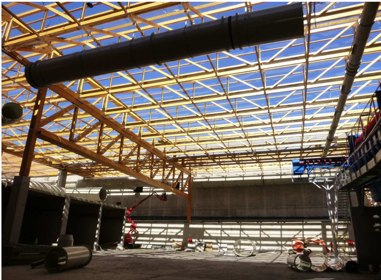
Extérieur de la Plate-forme de compostage – Toute charpente installée, pose de la toiture en sept. 2015 (photo de septembre 2015)
