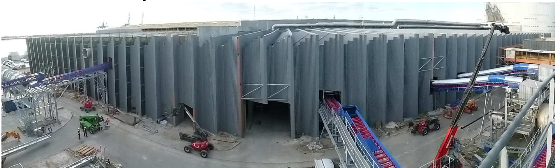
Vue panoramique de l'extérieur du bâtiment de tri primaire (et de la plate-forme de compostage sur la gauche) (photo de fin octobre 2015)
